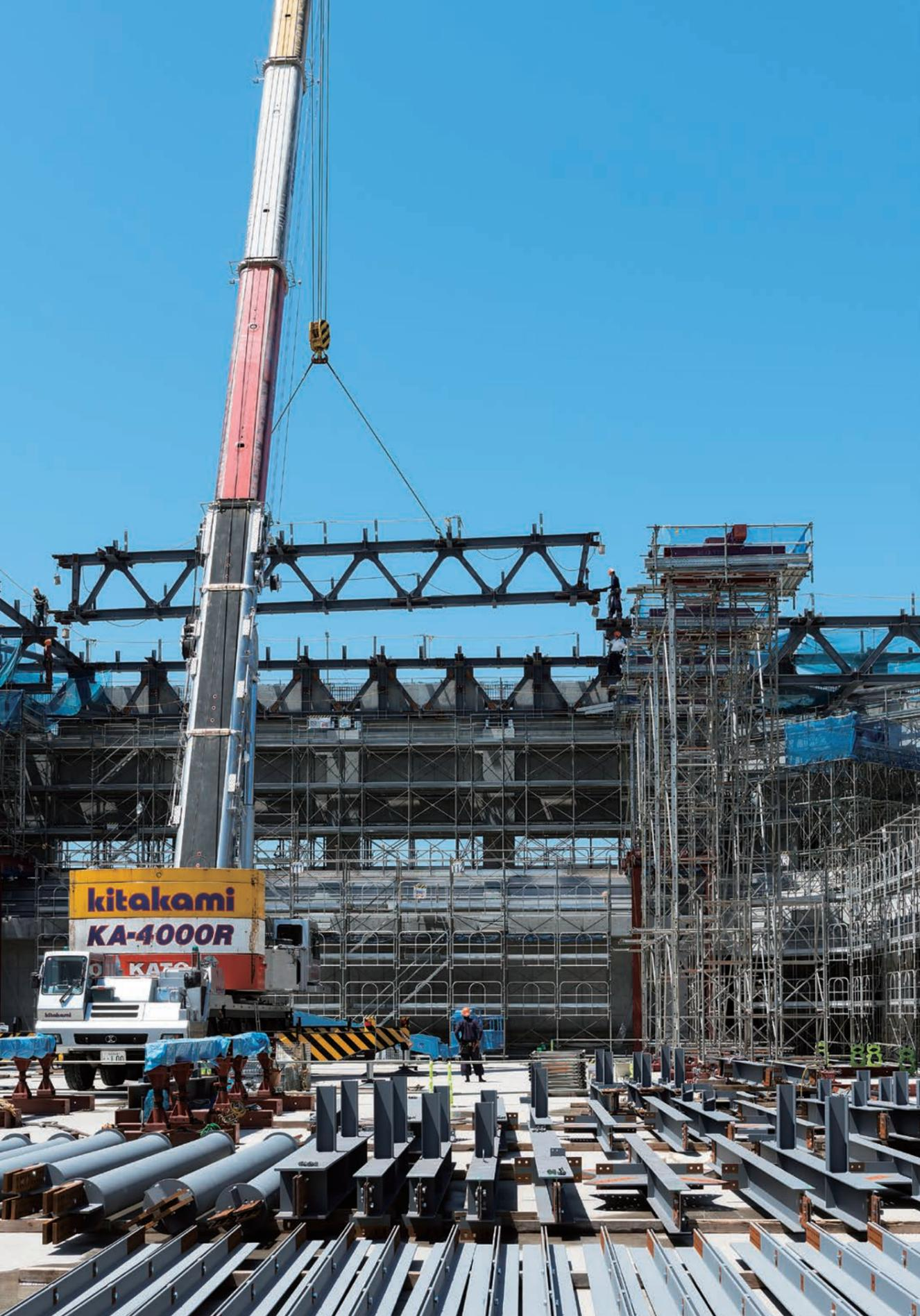
メインアリーナで200t仕様のオールテレーンクレーンを使い、トラス梁を架け渡す。54mのスパンを3分割した中央部のトラス梁。細心の注意を払いながらトラス設置作業を進める。
