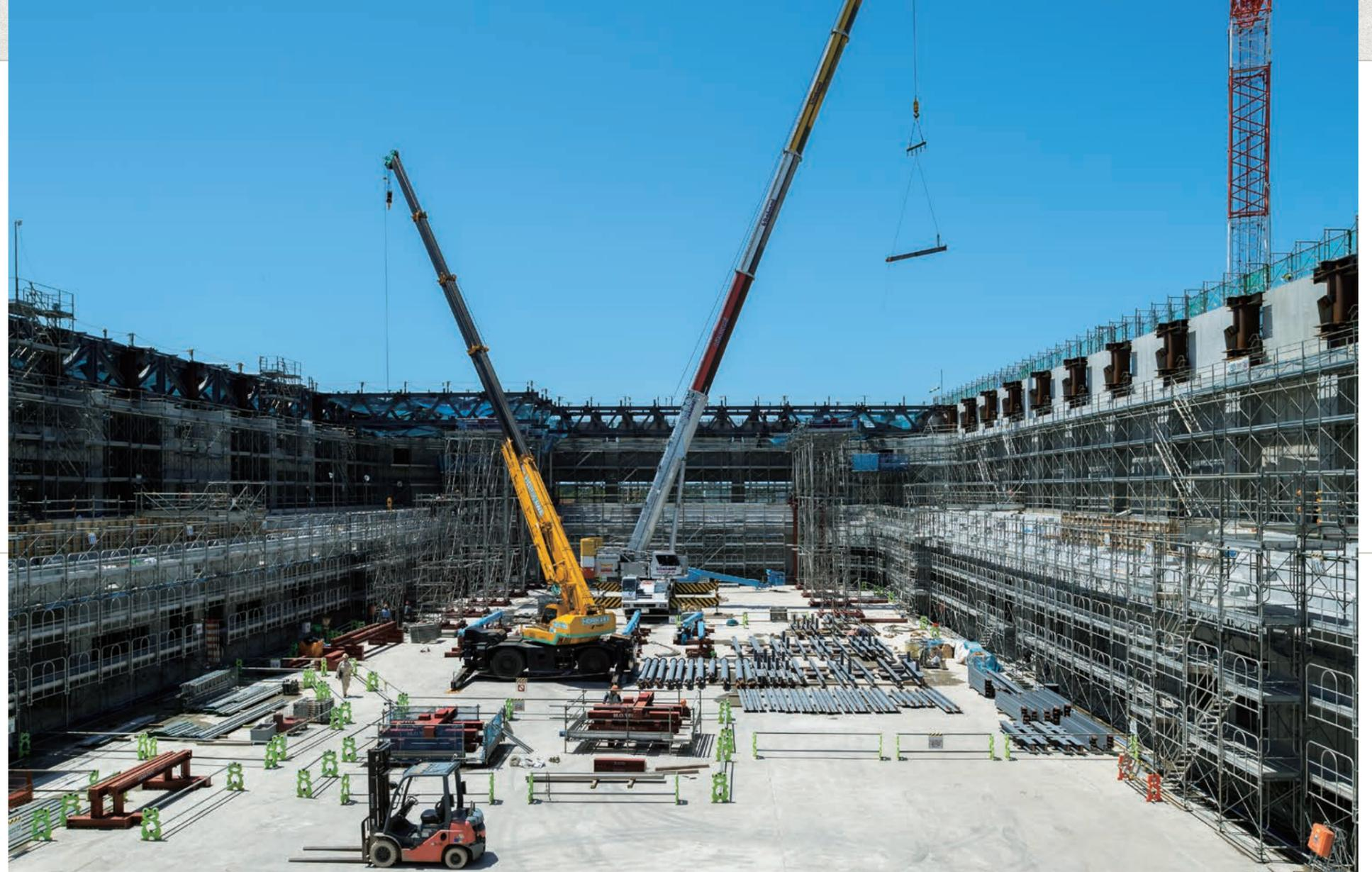
屋根鉄骨の建て方が進むメインアリーナ。ヤードの広さは3,500㎡。手前の35tラフタークレーンで鉄骨梁の地組みを行い、奥の200t仕様のオールトレーンクレーンで建て方を行う。吊っているのは小梁。アリーナの外にも組み立てヤードがあり、3分割した北側の梁を外から200tクローラークレーンで設置していく。
